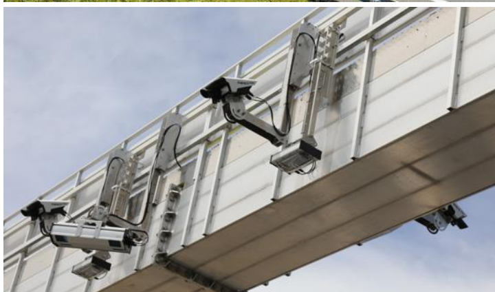
Les capteurs de détection savent associer la plaque à son véhicule, écartant toute mauvaise surprise ou erreur de lecture lors de la sortie de l'autoroute. Photos AREA
