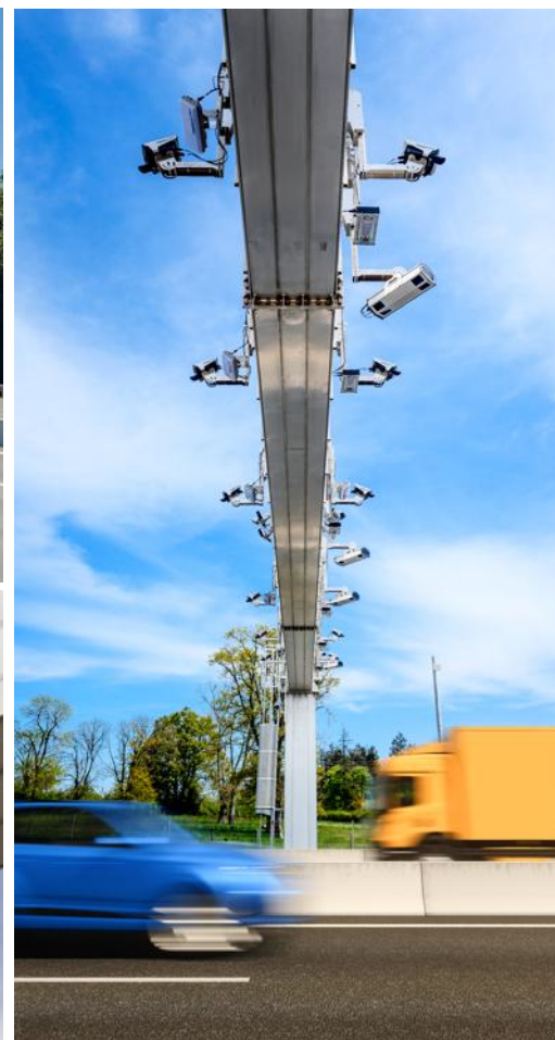
Les capteurs de détection savent associer la plaque à son véhicule, écartant toute mauvaise surprise ou erreur de lecture lors de la sortie de l'autoroute. Photos AREA
