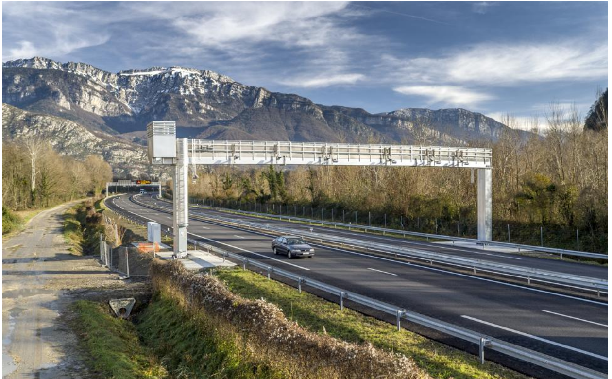
Portique d'entrée installé sur l'A49 au niveau de Saint-Quentin-sur-Isère, en Isère. Photo AREA
